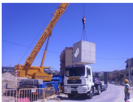
Foto: Caixa Saneamento - Metro (Gondomar)
